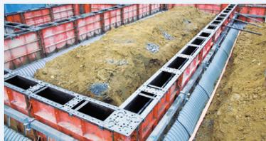
基礎については、1972年から基礎工法の研究を重ね、1974年には、メタルフォームを使用した基礎枠型に生コンクリートを一気に流し込むことで、均質で強固、作業効率にも優れた「1260基礎」を開発。その後、品質安定と省力化、耐久性向上の研究開発に着手し、1992年には、土台を介さず、躯体と基礎を直接ジョイントさせる当社独自の「1660基礎」を開発・導入しました。これにより、1995年の阪神・淡路大震災でも当社の建物は全壊・半壊ゼロ棟という実績を出し、当社の基礎の完成型として現在も使われています。
