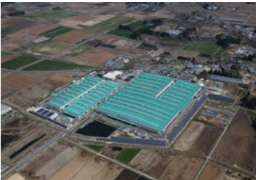
Tohoku Factory mega solar
