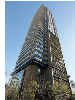
上町一丁目タワー：敷地の43%を緑地とし、さらに大規模な壁面緑化も備えた環境配慮計画
